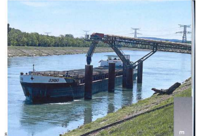
Deux péniches de 80 m de longueur acheminent alternativement les granulats de la carrière vers les deux centrales de BPE lyonnaises au port Edouard Herriot. Pour le retour, elles sont chargées de matériaux inertes qu'elles livrent à Mondragon.
